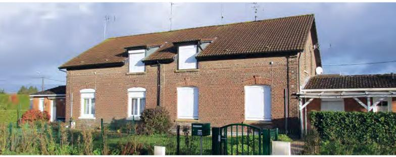
Les travaux concernent la réhabilitation thermique de logements individuels. L'ensemble des menuiseries extérieures est changé, les doublages existants sont déposés et d'autres, plus performants d'un point de vue thermique sont mis en œuvre. Les isolations des combles, des caves et des accès au cave sont améliorées.
